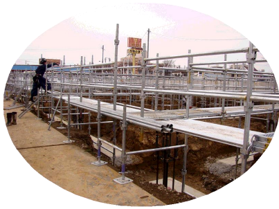
現在は、足場を組んだ状態 (3月下旬)
